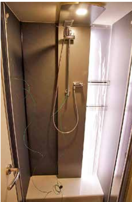
Metallplaten fra gulv til tak midt i dusjen ser ut som et dekorelement, men er også en enorm varmeflate.
